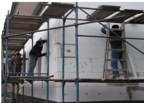
Nowoczesne techniki budowlane – ćwiczenia z docieplania budynków
